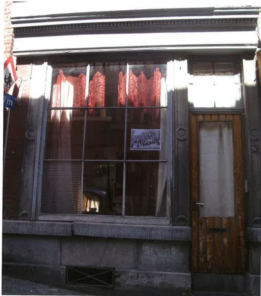
Rue Pierreuse, intéressante fenêtre à petits bois qui a échappé à la modernisation. Ce type de châssis devrait être protégé.
